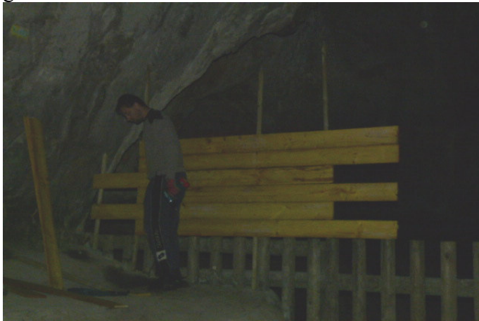
Montage de la barrière de gauche
